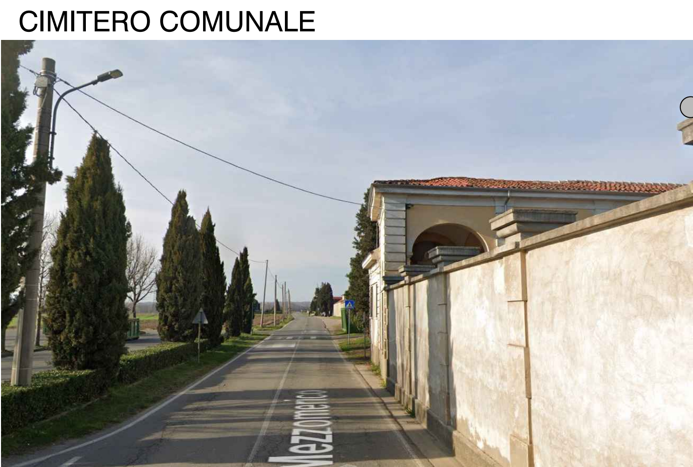
LATO OVEST SP 18A, TRATTO A NORD DELL'INCROCIO CON VIA FONACI
